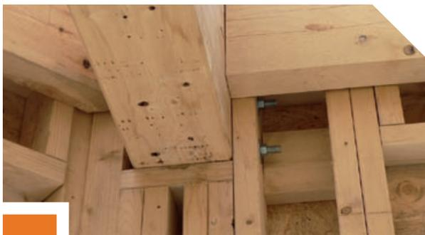
Descente de charge poutre sur mur façade
